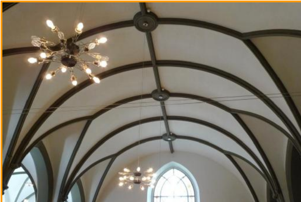
Detailaufnahme (Große Markthalle)
